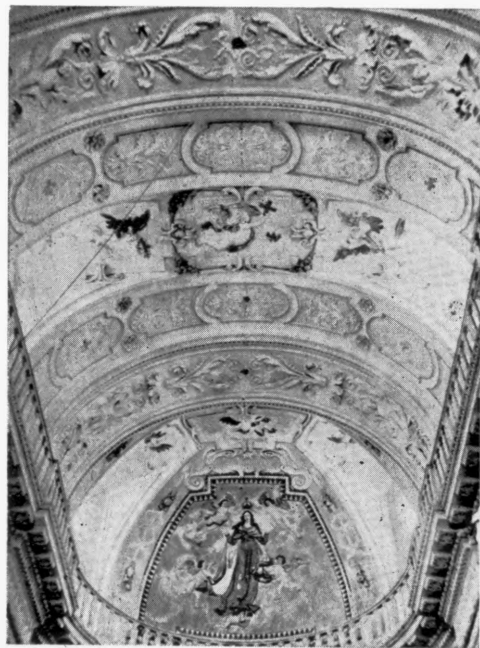
Fig. 22. Tarłów, kościół par. Dekoracja stiukowa sklepienia prezbiterium ok. poł. w. XVII (s. 24).
