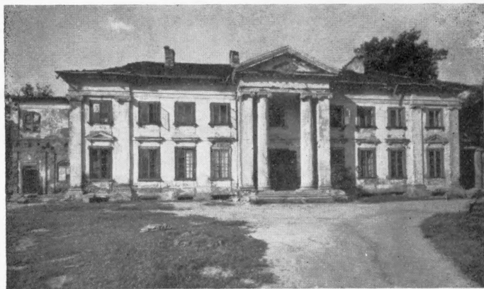
Fig. 25. Studzieniec, pałac ok. 1790, arch. H. Szpilowski . Fasada (s. IX, 40).
