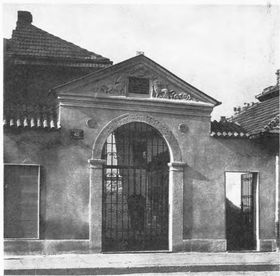
Fig. 37. Bóżnica Remu. 1557. 1829 arch. A. Pluszyński , 1933 arch. H. Gutman . Widok na bramę wejściową (s. 10, 13).
