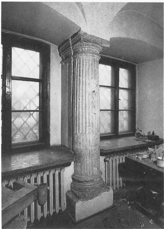
Fig. 45. Dom kahału, ul. Józefa nr 40. Kolumna międzyokienna w pomieszczeniu na parterze. po 1556 – przed 1563 (s. 16).
