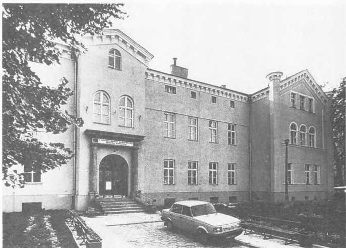
Fig. 90. Dawny szpital żydowski przy ul. Skawińskiej nr 8, 1861-6 arch. A. Stacherski, 1922-7 arch. Z. Prokiesz, 1929 arch. J. Weinbergen (s. 40).
