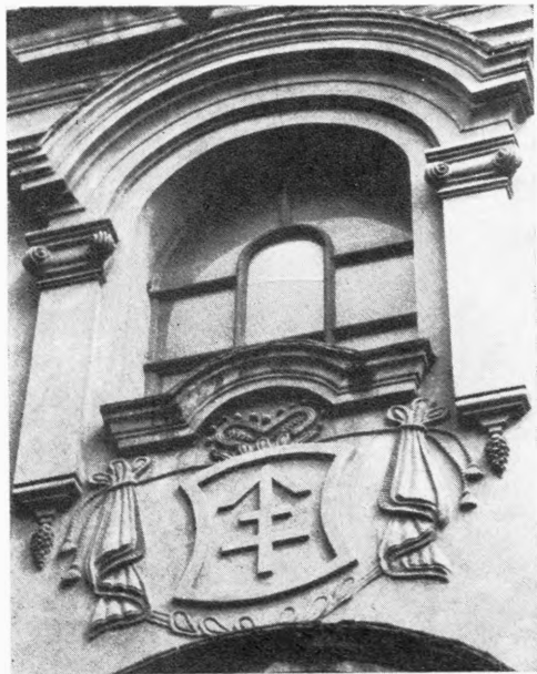
Fig. 40. Koźmin, kościół par. Okno w fasadzie zach. ok. 1670 (s. 20).
