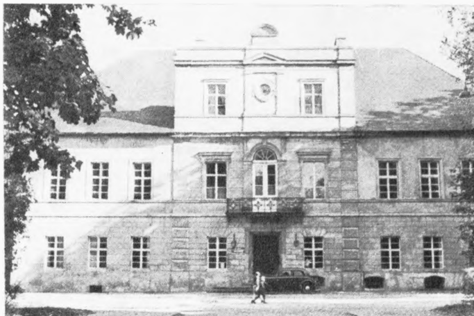
Fig. 51. Krotoszyn, pałac 1692—1700 i ok. 1819. Widok od frontu (s. 41).
