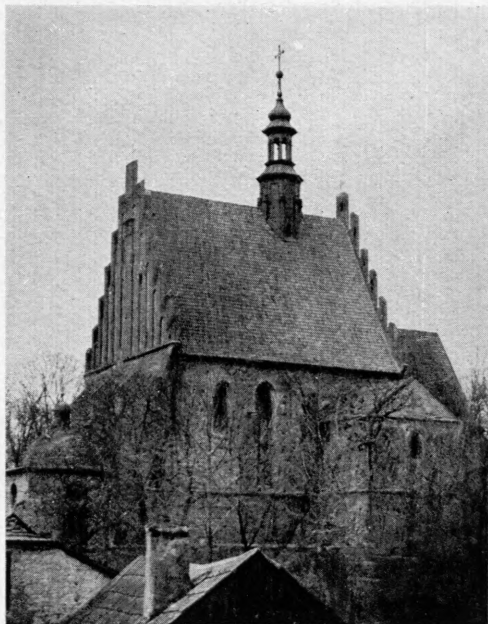
Fig. 4. Szydłowiec, kościół par. 1493 — ok. 1520. Widok do pd.-zach. (s. 42).
