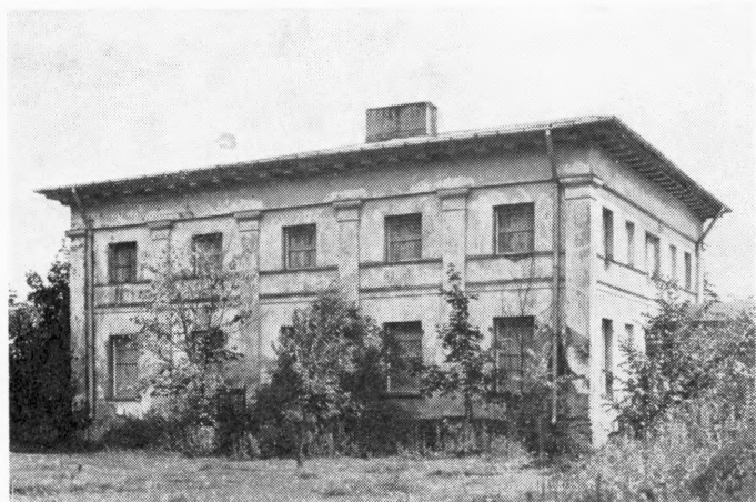
Fig. 20. Szczawin, pałac ok. 1830 arch. A. Idźkowski , korpus główny. Widok od ogrodu (s. 37).
