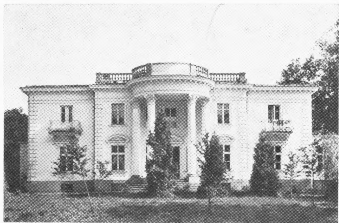
Fig. 21. Brzeźno, pałac ok. 1900 arch. L. Marconi . Widok od frontu (s. 1).
