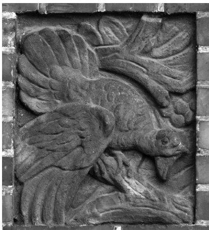
Fig. 166. Czernice, dwór, 1913. Detal elewacji – płaskorzeźba z motywem ptaka.
