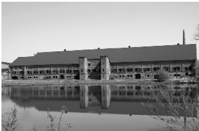
Fig. 176. Krzemlin, d. obora, 3. ćw. w. XIX. Elewacja zewnętrzna.
