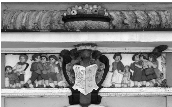
Fig. 217. Lipiany, szkoła ul. Kościuszki nr 1, płaskorzeźba z elewacji, ok. 1910.
