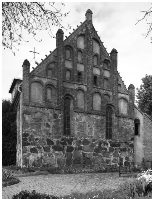
Fig. 80. Warnice, kościół par., 2. poł. w. XV, 1. poł. w. XVI, 2. poł. w. XIX. Elewacja wsch.
