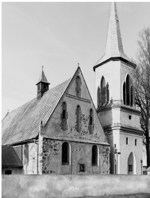
Fig. 54. Brzesko, kościół par., ok. 1300, wieża 1814-1817. Widok od pd.-wsch.
