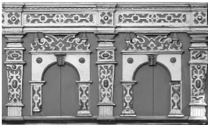
Fig. 327. Przelewice, kościół par. Fragment parapetu d. empory pd. (?), 1. ćw. w. XVII.
