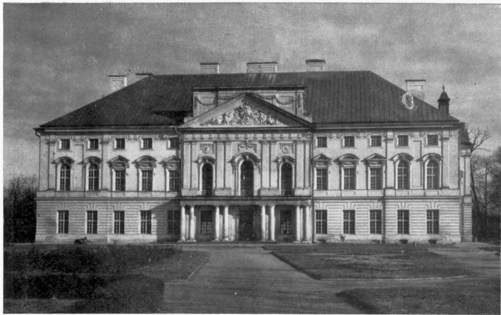
Fig. 37. Lubartów, pałac 2. poł. w. XVII i 1722—41, arch. Paweł Antoni Fontana , odbudowa 1950—70. Fasada (s. IX, 38).
