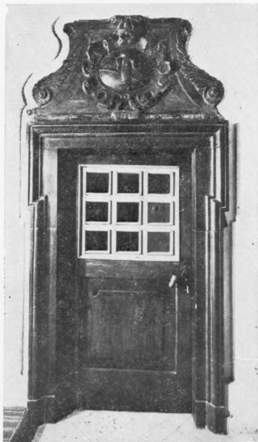
Fig. 20. Nieporęt, kościół par. Portal do skarbcza po 1651 (s. XI, 48).
