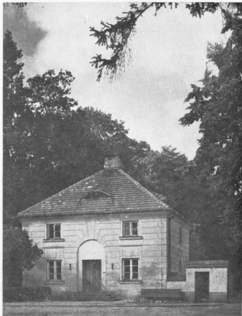
Fig. 38. Jabłonna, pawilon prawy 1780—2 arch. S. B. Zug i 1834—43 arch. H. Marconi (s. XIV, 21).
