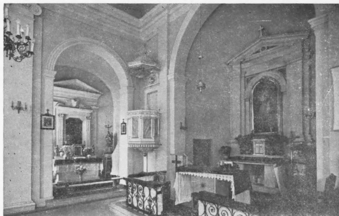
Fig. 27. Łomna, kościół par. 1870—2 arch. H. Marconi. Wnętrze (s. XII, 33).
