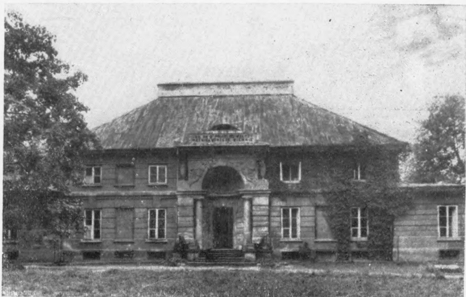
Fig. 23. Peçice, pałac 1808—9, arch. Fryderyk Albert Lessel . Fasada (s. 25)
