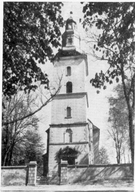
Fig. 3. Runowo Krajeńskie, wieża kościoła par. 1606—7. Widok od zach. (s. 14).
